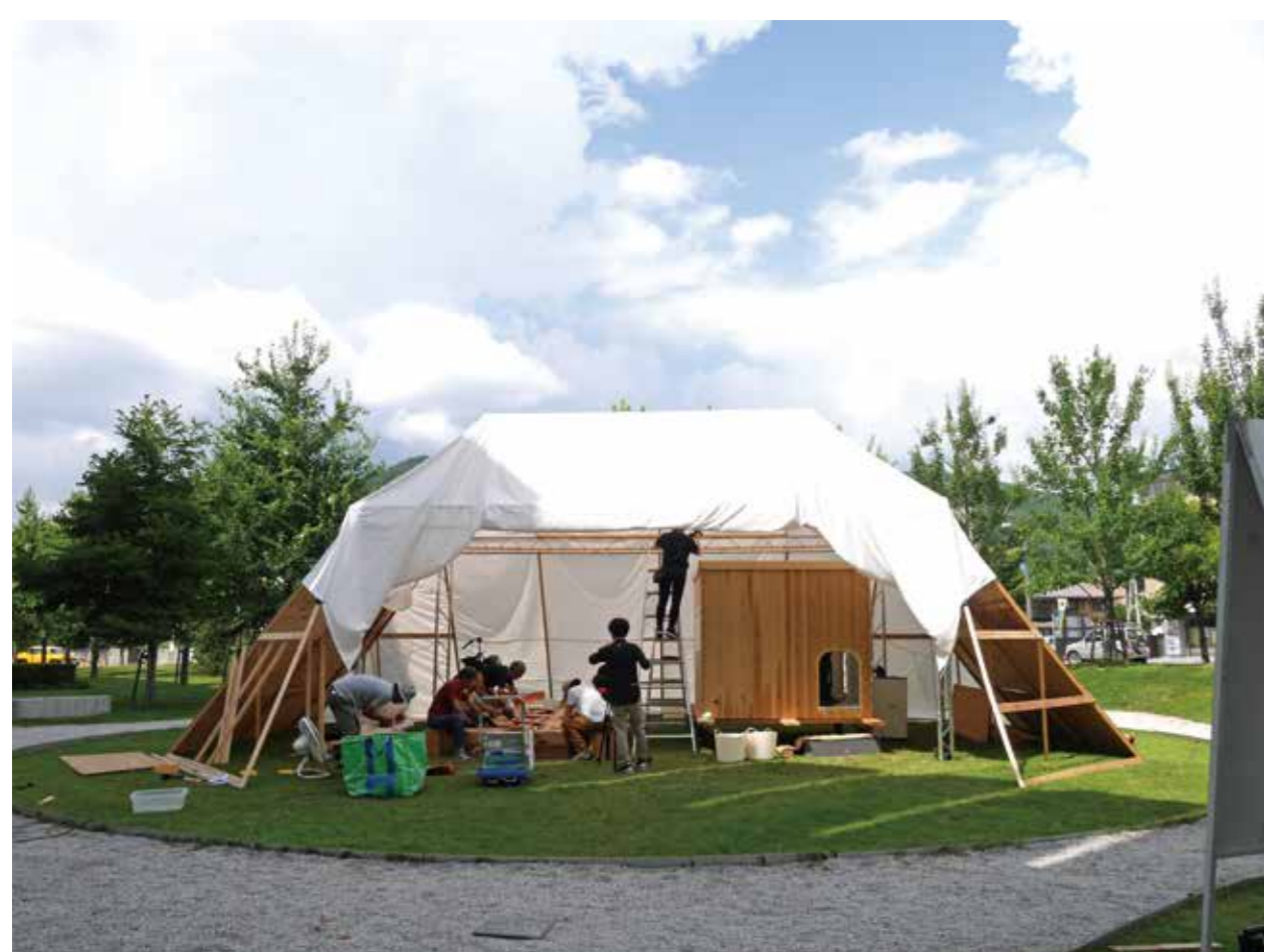
「低過庵」制作ワークショップの様子。 室内の漆喰塗りと銅板に凸凹をつける 作業を行なっています。 (8月12日)
